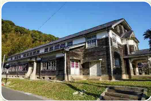
旧波佐見町立中央小学校 講堂兼公会堂 外観
